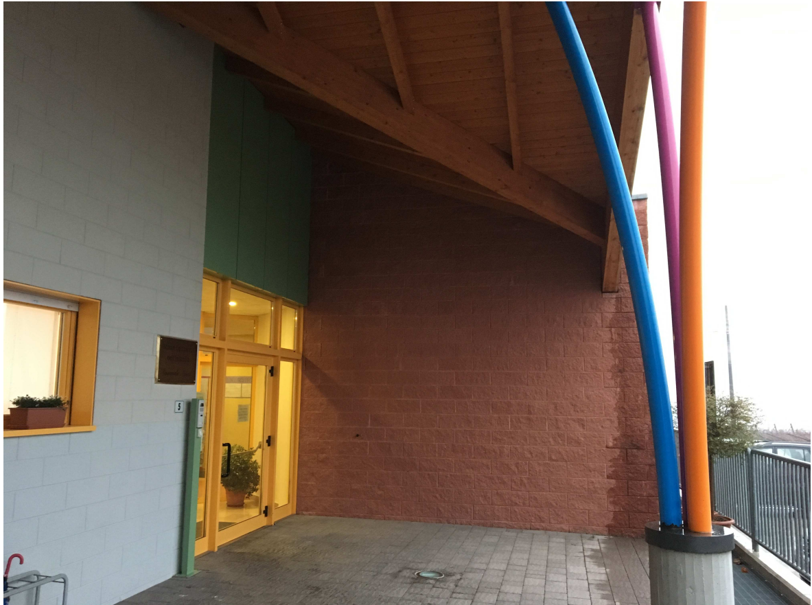
Foto 1: parete posizione opera.
